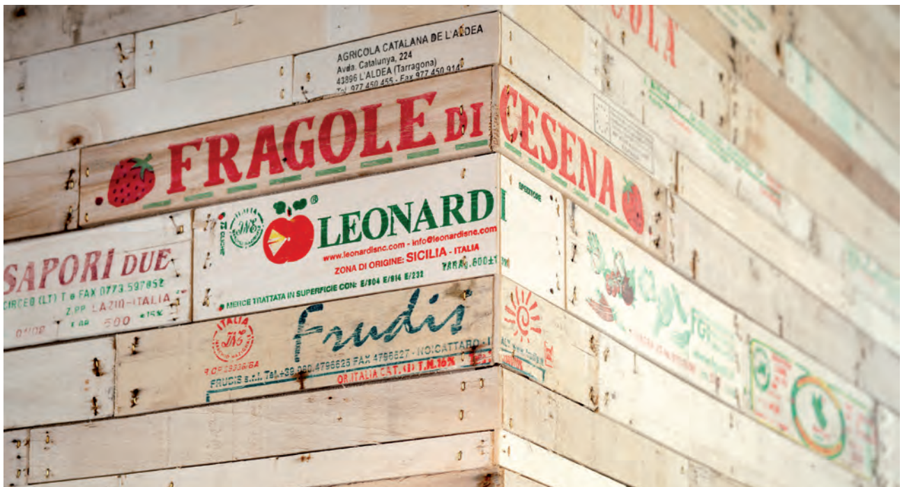
Innenraum im Erdgeschoss der VinziRast: Über Monate hinweg wurden Teile hunderter gesammelter Obst- und Gemüseboxen zu einer vielschichtigen Innenraumverkleidung zusammengestellt,... (Foto: Kurt Kuball)
