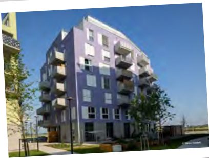
Kolokation Am Seebogen, Ostansicht
