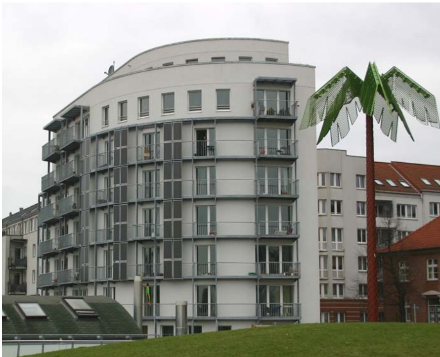
Baugemeinschaft Parkhaus e.V. am Pinnasberg in Hamburg/St. Pauli, Auftraggeber St. Pauli Hafensträßengenossenschaft e.G., fertiggestellt 2003 von Plan-R- Architekturbüro Joachim Reinig, Baubetreuer Stattbau Hamburg. Es handelt sich um Deutschlands erstes Passivhaus mit acht Vollgeschoßen. Foto: Plan-R- Architekturbüro
